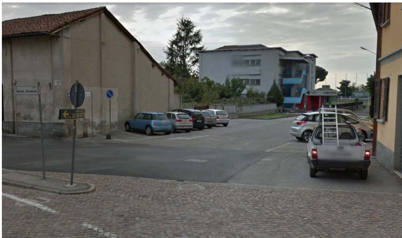
Vista esterna dell'edificio, dalla via Fenini (ingresso del cantiere)
